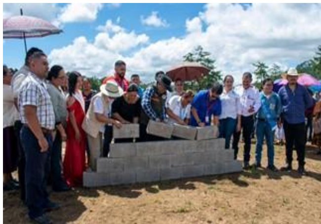
Imagen 20. Instalación de la primera piedra para la construcción del edificio del Instituto Francisco Morazán.
