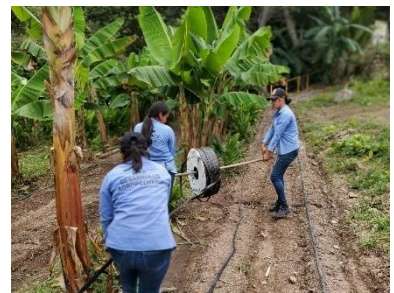
Ilustración 66: Estudiantes del instituto Salomón Sorto Zelaya instalando sistema de riego por goteo. (Fuente: Red ITC).
