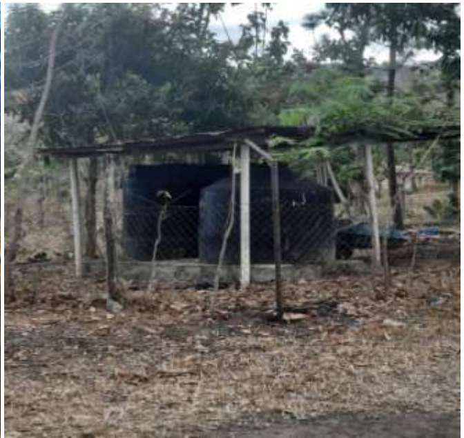
Tanques de agua para almacenar agua para uso de limpieza y pequeños viveros.
